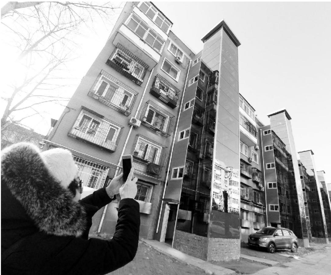
区全面启动既有多层住宅增设电梯试点工作,在全区广泛征集居民意见,动员有需求的老旧小区住宅楼加装电梯。从2017年8月至12月,全区老旧小区的住宅楼已有214部电梯开工实施。由于工程涉及拆改地下管线,打地基等程序,较为耗时,4个多月来,包括牡丹园小区、北航社区、毛纺北小区、大柳树和海洋社区的31部电梯已经完成安装验收,可供居民正式使用。
