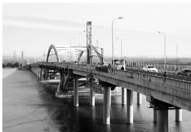
160台大吨位千斤顶顶起万吨引桥
