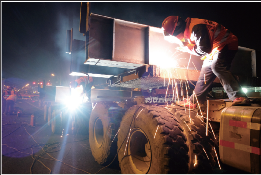
吊装前,工人对拖车上的桥梁托架进行焊接。
