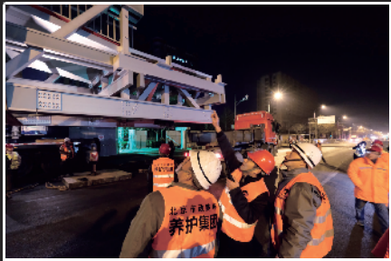
现场指挥和技术人员研究吊装主梁整体行走轨迹。
