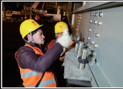
工人在桥梁主体上安装桥座钢垫。
