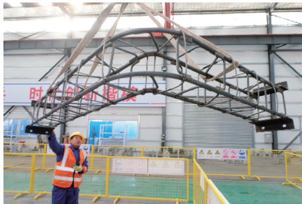
工人正在调装大型钢筋构件
