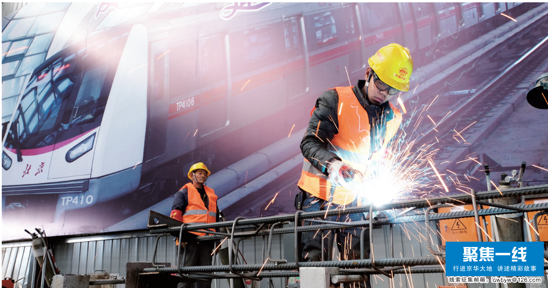
数控钢筋加工厂占地面积约2200平方米,相当于5个半标准篮球场的大小,工人们在干净无尘的施工环境中进行焊接作业
