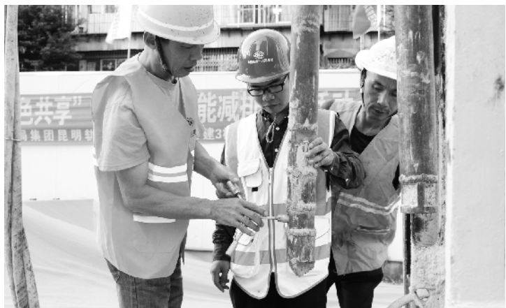
李国伟（中）协助工人一起更换钻头
