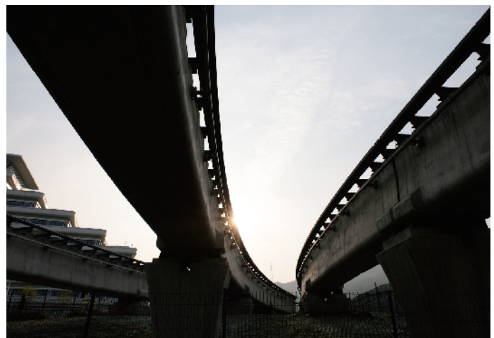
磁浮列车轨道目前已经全面建成。
