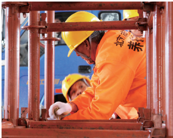
支撑钢架结构做到分毫不差。
