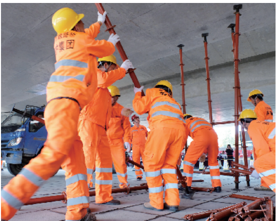
抢修工人只用10分钟就搭建起两组支撑钢架。
