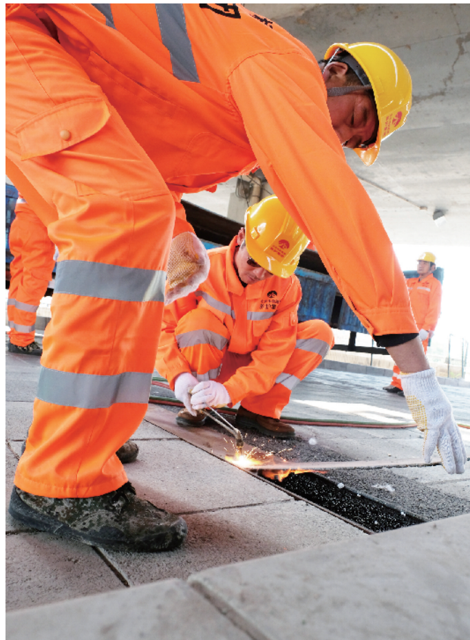
工人对撞击损坏钢板进行切割。
