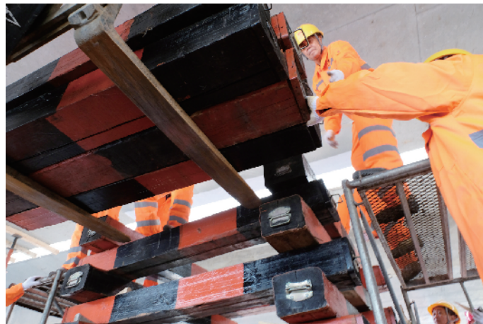
抢修人员只用40分钟，就搭起了临时支搭支撑起受损桥体。
