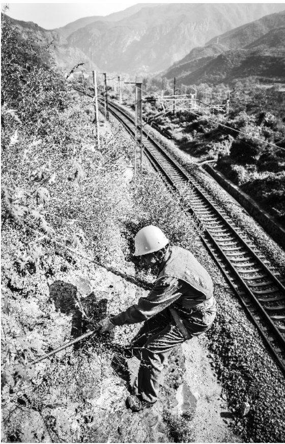
十几米峭壁，工人一手握着撬棍，一手掌握悬挂的平衡，熟练地剔除峭壁上松动的岩石。
