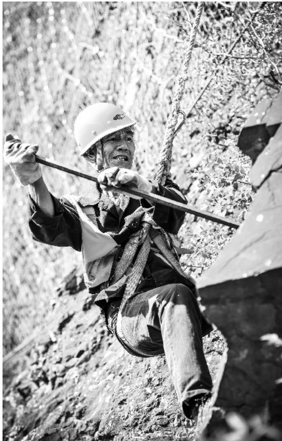
十几米峭壁，工人一手握着撬棍，一手掌握悬挂的平衡，熟练地剔除峭壁上松动的岩石。
