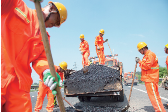
为保证路面平整，还要用水平尺测量后，才算完成。工人们将高达上百度的热沥青洒到切割好的补坑内。
