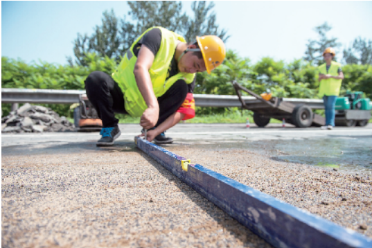
为保证路面平整，还要用水平尺测量后，才算完成。工人们将高达上百度的热沥青洒到切割好的补坑内。
