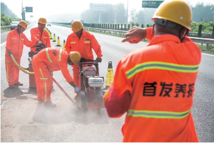
路面切割工作开始，热浪裹挟着砂石蔓延，呛得人无法呼吸。
