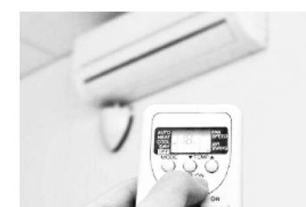
只要把空调模式从“制冷”调成“除湿”，不仅能让房子如冰箱般凉爽，还可以少花很多钱，对人体的伤害也能降到最低。因为“除湿”模式时，室内吹风机将保持低速运行，压缩机也间断运作，如此不断地循环，使室温保持在设定的温度附近。
