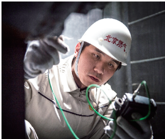
班组对路面管线部位进行检测。
