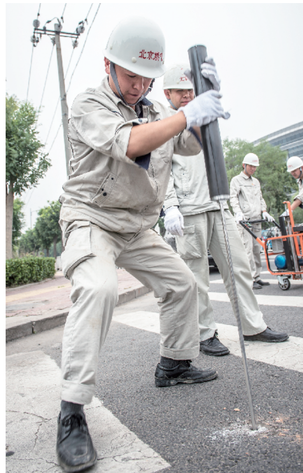
队员们在漏气点沿管线位置，在地面上进行打孔检测。
