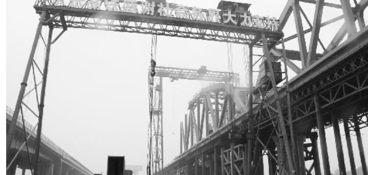
部在岸边拼装,通过推拉方法吊到湖面中间,从而减少湖面作业时间;另外,钢梁拼装的精度要求高,一孔梁大概有3万多条螺栓,
