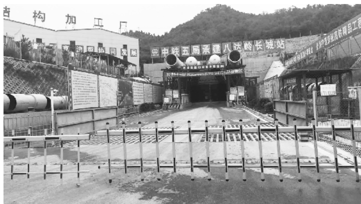
正在施工的京张铁路八达岭长城站区。
