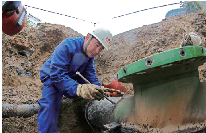
张海军在抢修燃气管道。
