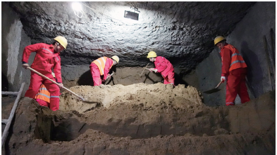
在一些地下情况复杂的区域，采用矿山式挖掘是最行之有效的施工方案。
