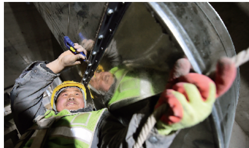
风管的螺丝是否安装合适，需要人工检查一遍。
