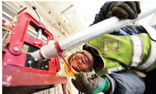
管道之间的连接需要用油漆封一下口。
