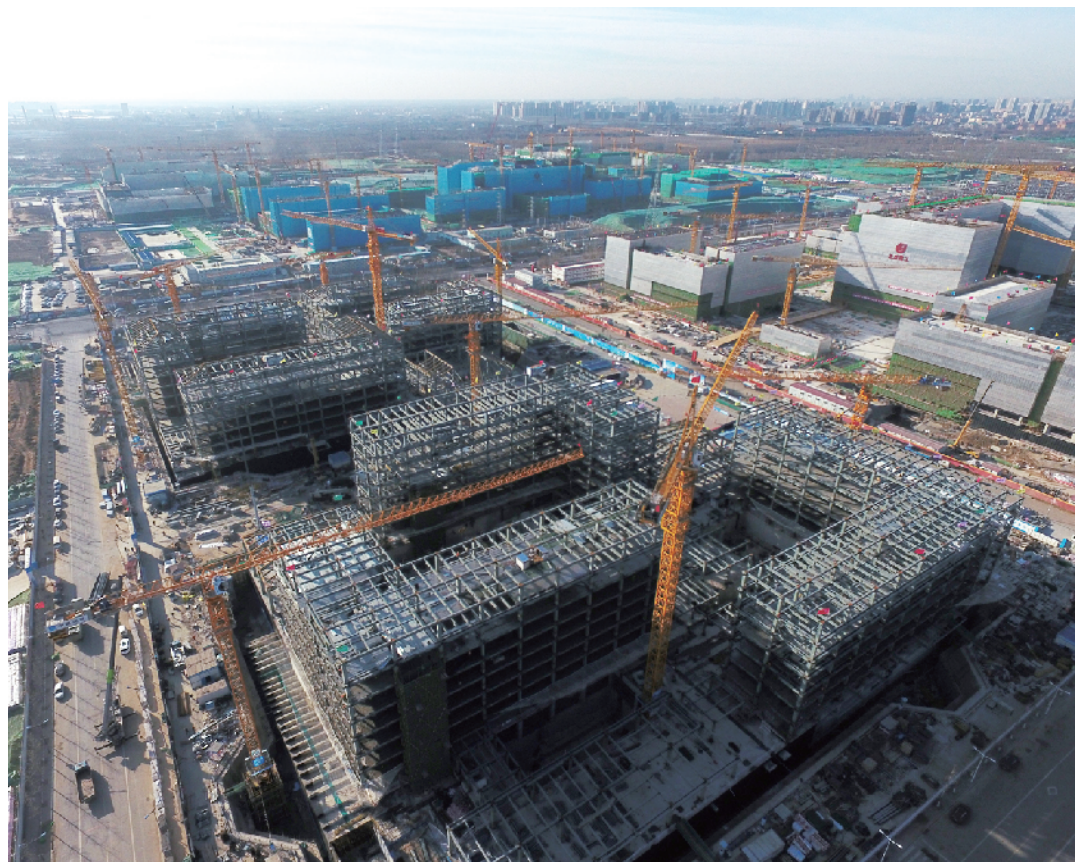
建设中的北京城市副中心。
