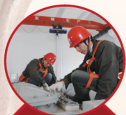
电气设备安装工
