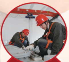
电气设备安装工
