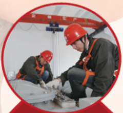
电气设备安装工
