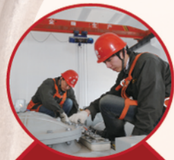
电气设备安装工
