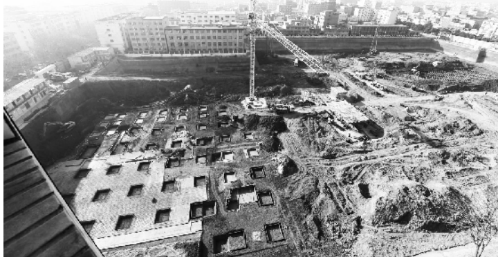
图为河南汝州望嵩文化广场施工现场，画面右下方为原有墓葬坑主要所在区域，如今已被夷为平地。
