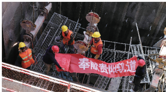
在地铁施工井口青年职工挂出“奉献贵阳”的横幅。
