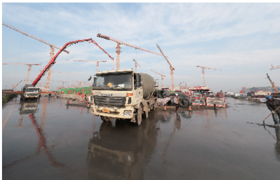
尽管施工量大,但水泥浇灌没有尘土。
