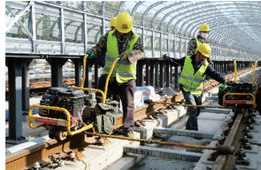
轨道安装后两台测试仪同时测试。
