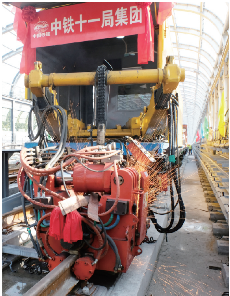
大型“机器人”进行自动焊接。
