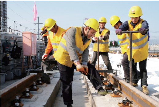
固定轨道要几个人同时进行以保障轨距精确。
