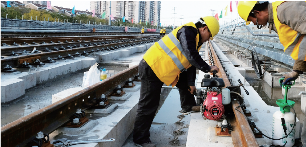
轨道安装完成工人要进行压力测试。
