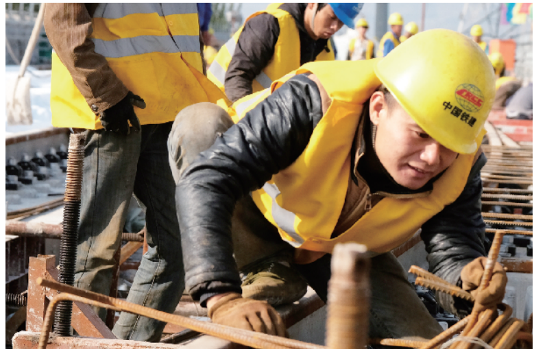
工人对每一根钢筋要进行核对。
