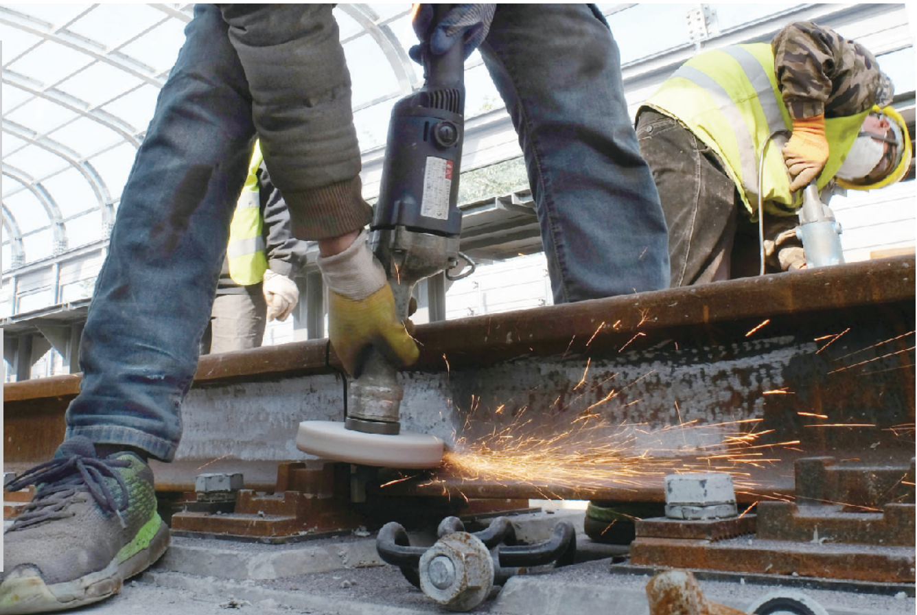
铁轨的每一个接缝在焊接前都要仔细打磨。
