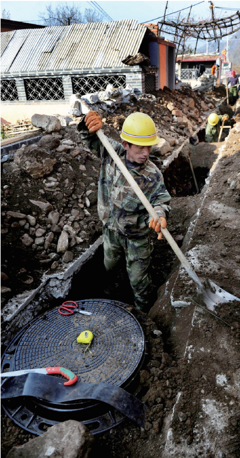
工人重新铺设上下水管线。
