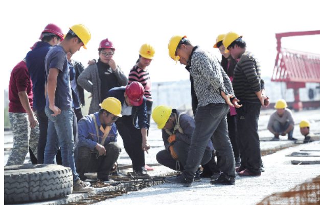
市民观看工人绑扎钢筋。
