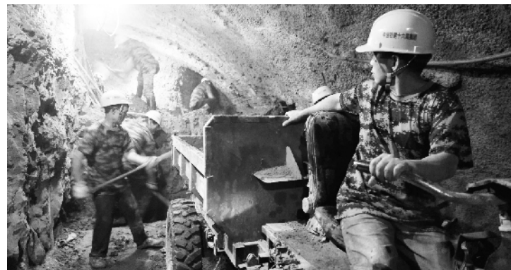
通,取得了阶段性胜利。项目部将美术馆站科技攻关经验编写成册,申报专利,其中“高风险暗挖地铁车站施工关键技术”获得
