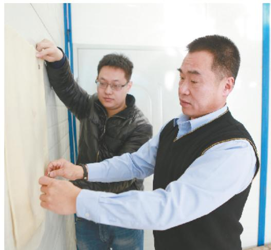
在中建一局二公司北京印刷学院项目，有一件特殊的“太空衣”。这件“太空衣”是由一种类似于海绵的材料和一种塑胶薄膜粘贴在一起制成的，外表看起来是奶黄色。“太空衣”的底边是封死的，上端开口，从上口浇水，由于海绵的强吸水性，源源不断地滋润着构件，保证了建筑构件的湿度，塑胶薄膜不透水，防止了水分的蒸发。给构件穿“太空衣”也很方便，用强力磁铁就可以将“太空衣”固定在混凝土构件上。这项发明，目前已经申请了国家实用新型专利。
