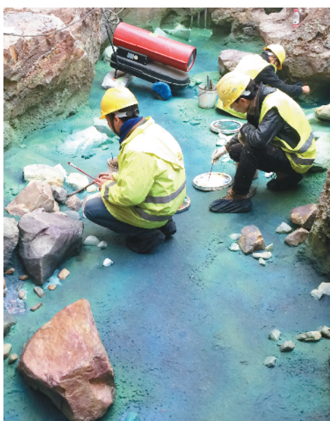
假山沙滩上色施工
