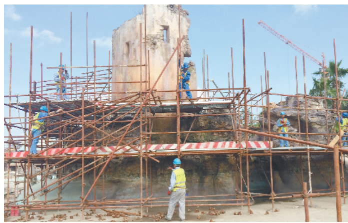
施工中的宝藏湾湖区灯塔
