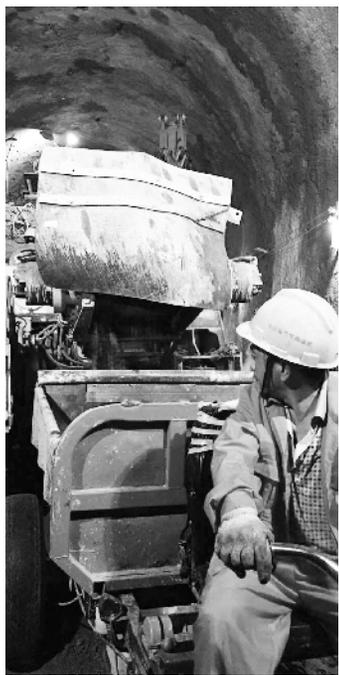
监测为一体，可迅速完成基桩、桩上钢管柱的施工作业，机械化作业误差非常小，在1公分以内。采用新设备使工效大大提高。之前打一根中桩需要15天，现在只需1天。之前打边桩要3至5天，现在可以一天打2根，使工期大大缩短，工效较传统工法提高10倍以上。目前，万泉河桥站车站主体结构完成20%，洞桩施工完成80%。
