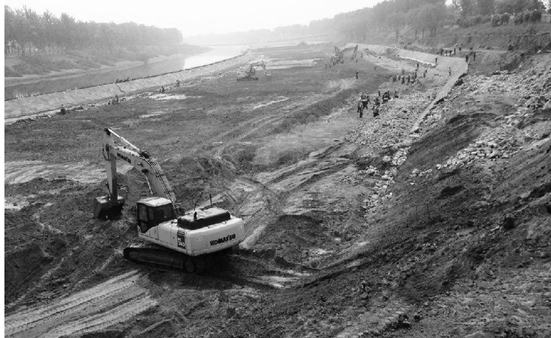
数十名工人与机械设备相互配合,开展施工作业……这是4月29日记者在凉水河河道治理工程第四标段看到的一幕,随着汛期到来,北京加速凉水河通州段治理,保证汛期安全。负责施工的中电建建筑集团相关负责人介绍,凉水河改造工程将对现河道进行清淤、疏通,新建、改建雨水口数十个,对拦河闸、橡胶坝等跨河水工建筑物进行改建,提高沿线地区的行洪能力,按照50年一遇洪水设计,100年一遇洪水校核。工程预计2017年3月31日完成土建施工。
