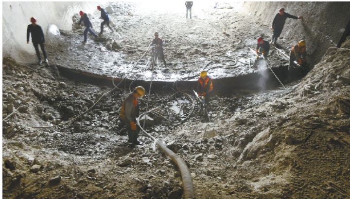
在土武一级沿线隧道，工人开始第二阶段施工作业。
