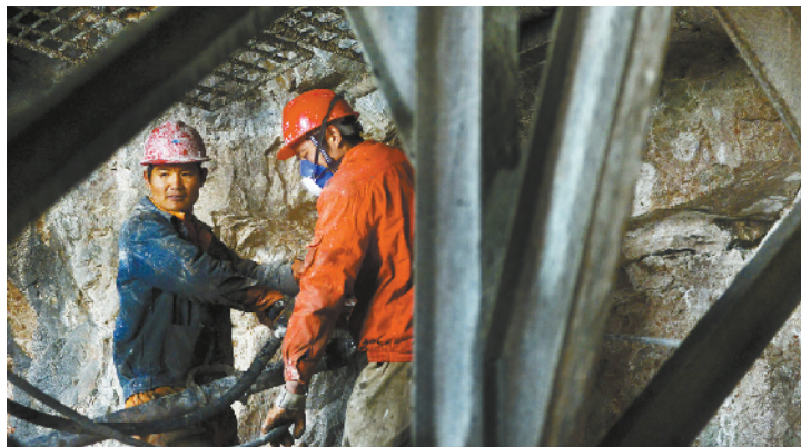
钻孔工在狭小潮湿的平台打出130个深2.5米的孔洞，至少需7个小时。
