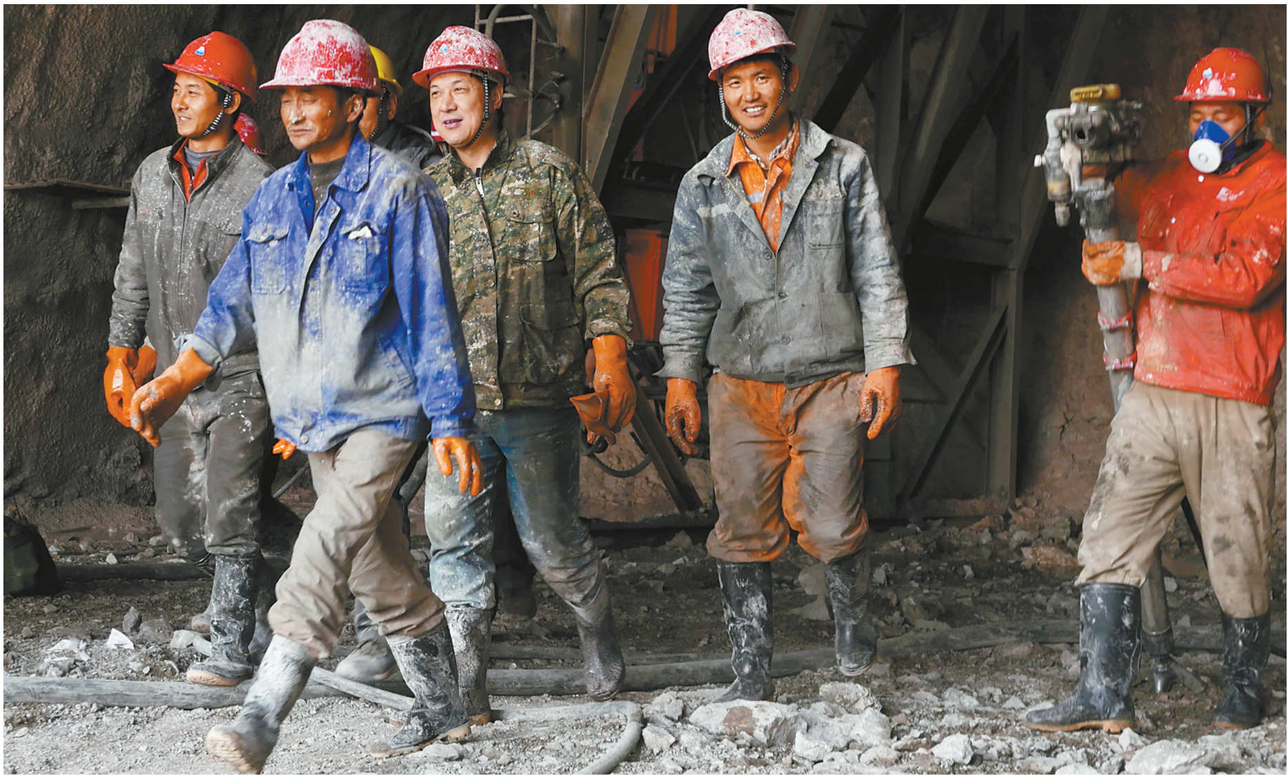
完成一天的工作，12名钻孔工人走出丹江口金岗山隧道。
