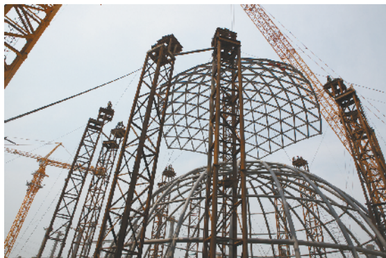
辽宁省科技馆外球钢结构吊装 梁冰
