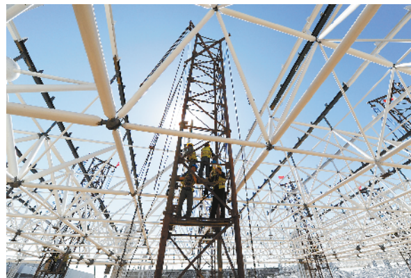
北京奔驰汽车厂房工程采用人工提升技术
