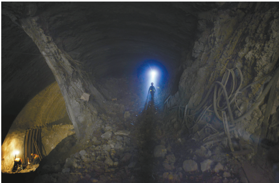
爆破工人穿过碎石堆查看爆破效果。
