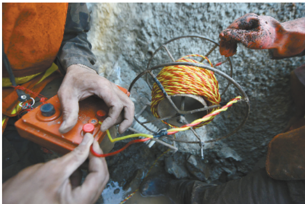
每根电线都要和起爆器连接妥当，确保万无一失。
