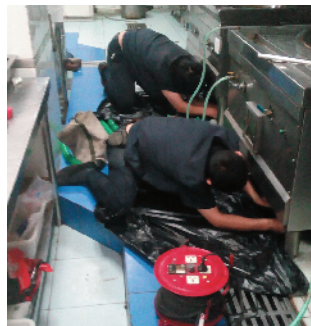
Z-72 修理灶台 北京房修一物业三分公司水务局项目 郭建伟/摄
