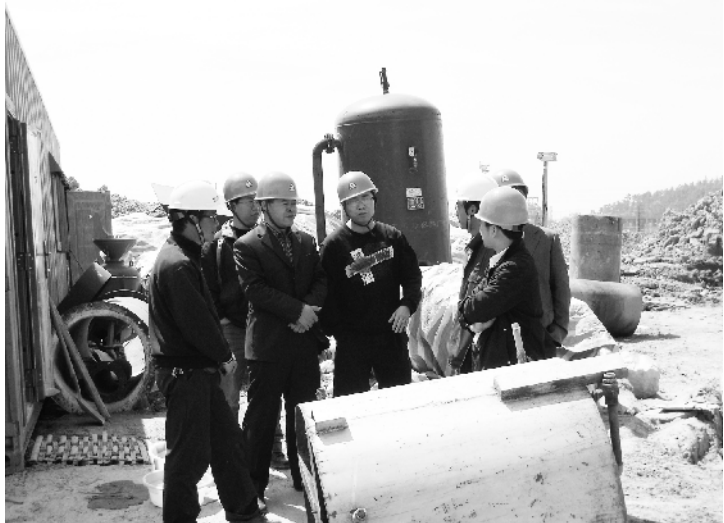
白金玉（左三）在施工一线检查
