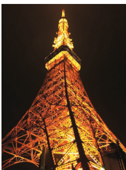
F-32 夜色东京塔 市政道桥工程总承包部 孙楠楠/摄
