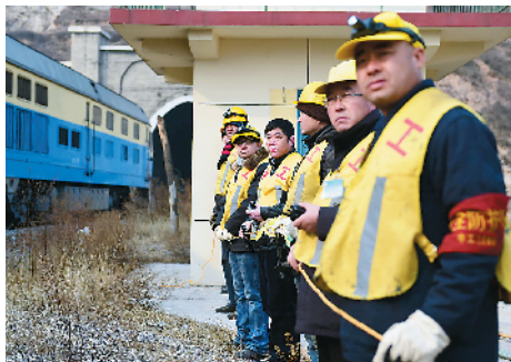
设好防护，戴上安全帽走入隧道开始工作。
