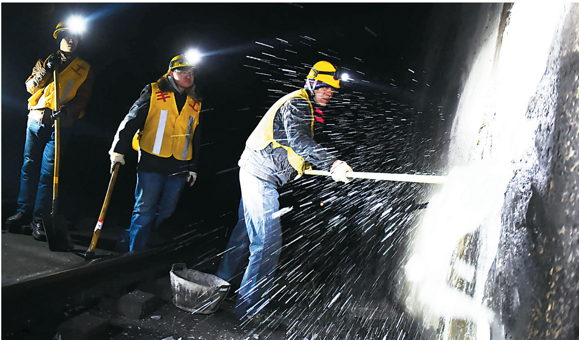
由于隧洞墙壁冰冻的很厚，工人要用镐铲除。
