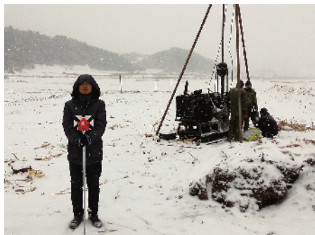
Z-13 冰天雪地中测量 中铁六局北京桥隧分公司 张嘉麟/摄
