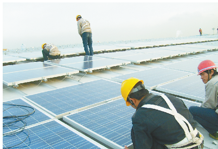
英利能源利用彩钢板夹具技术固定光伏电池
