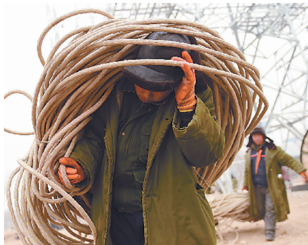
野外作业，行车不便，人力搬运是常事。
