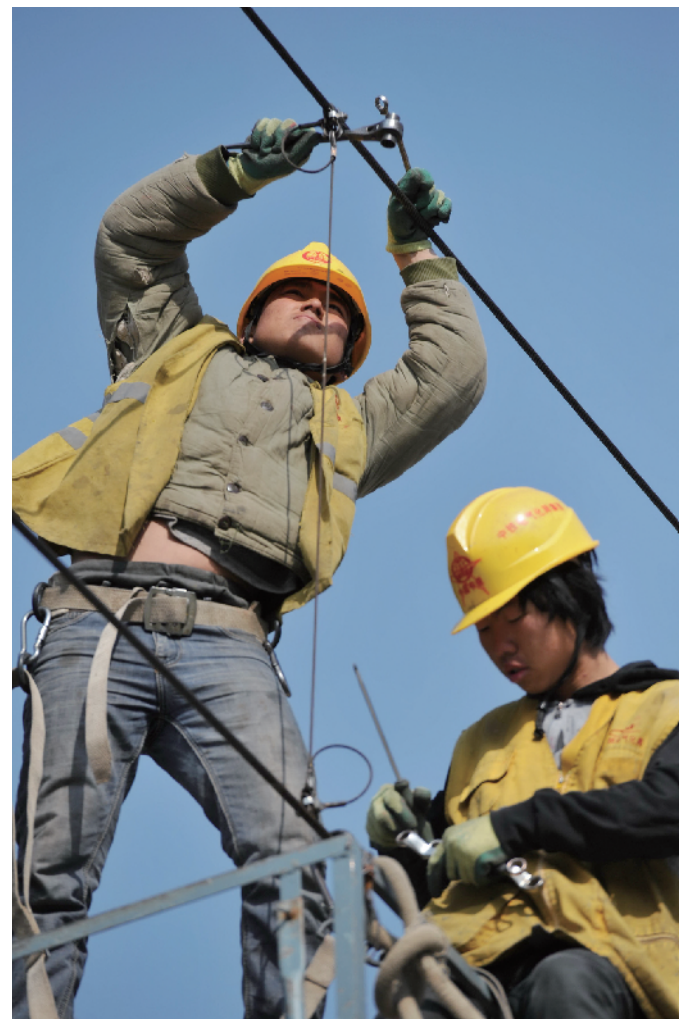
20岁的李伟和搭档在10米电网上调整导线,不超过2毫米的误差。
