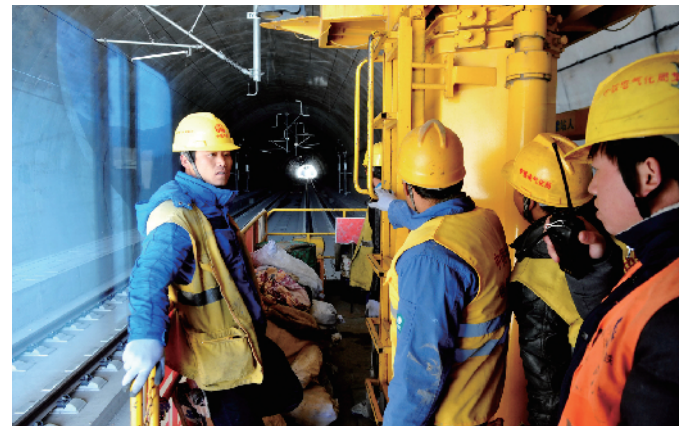
中午,班组工人乘机车驶出隧道,等待餐车到来。
