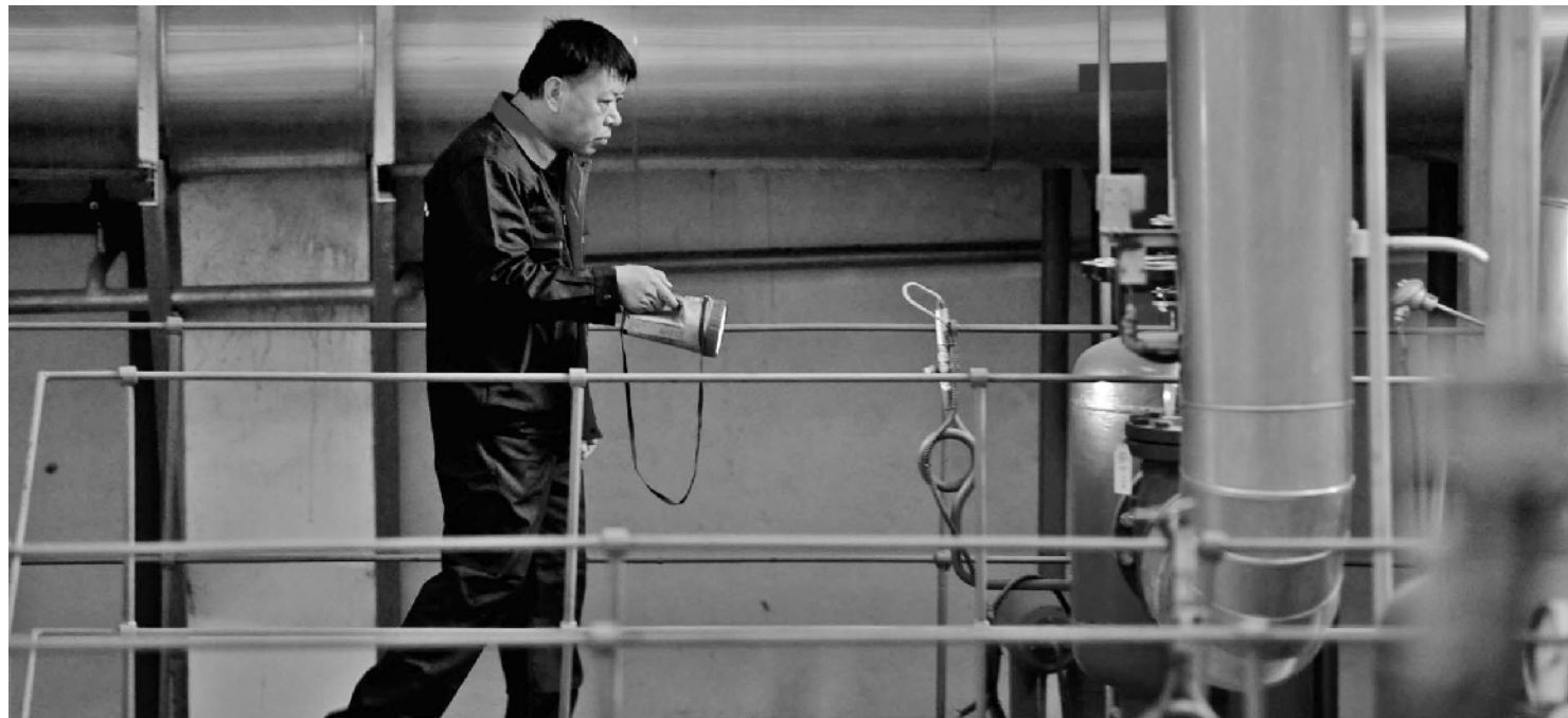
物业工作人员检查供暖管道。
