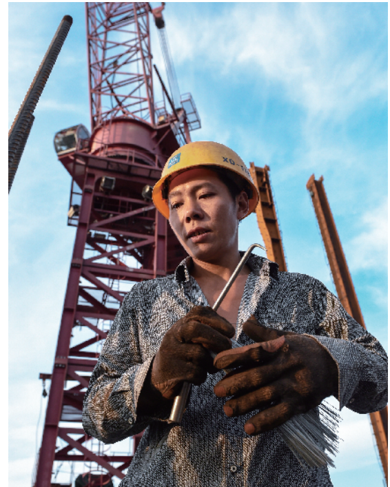
云端的钢筋工
