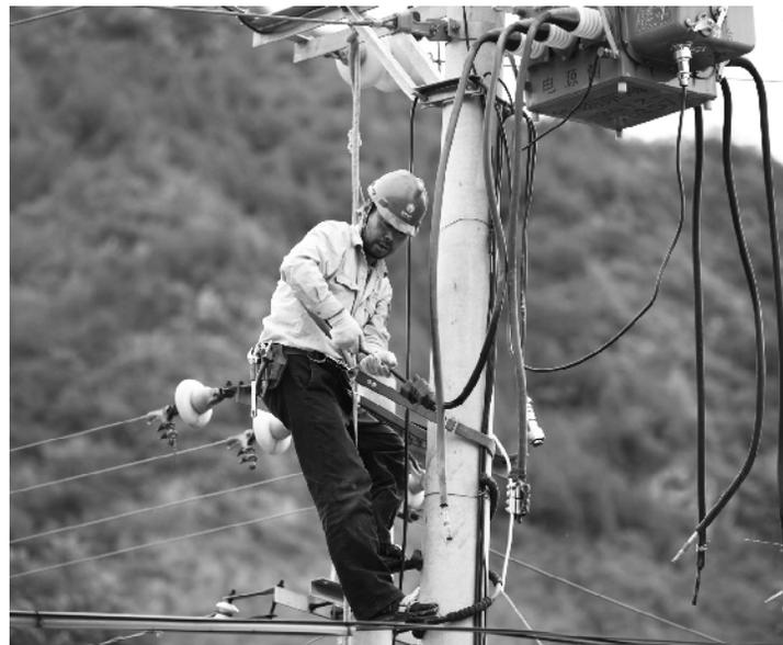
9月16日早8时，随着调度人员一声令下，门头沟10千伏架空供电线路田庄路全线停电，施工人员封挂地线，开始线路清扫、检修工作，国网北京门头沟供电公司正式开启2014年秋季线路清扫工作。
